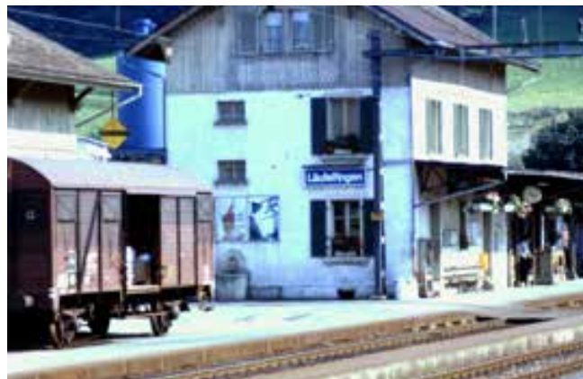
Der Bahnhof Läuelfingen in den 60er Jahren
